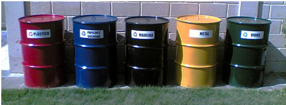
Figura 21 - Separação dos resíduos da construção civil depositados no canteiro de obras
